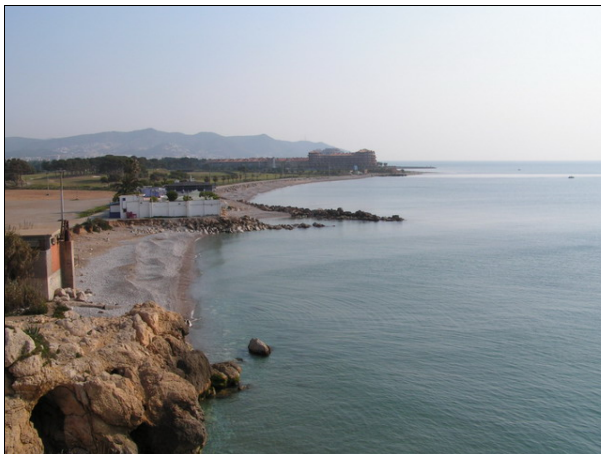
Fotografia 4. Instal·lació de l'Atlántida a primera línia de mar (ocupant ZDPMT) i terrenys denudats a la part del darrera d'aquesta edifici.
