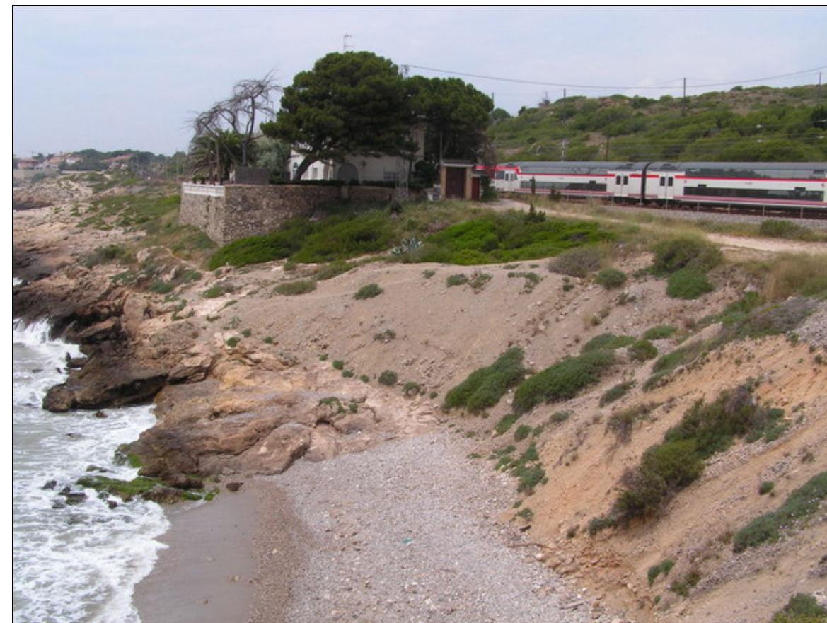
Fotografia 1. La Sal, edificació localitzada en la zona protegida pel PDUSC de Punta Llarga-Platja de Sant Cristòfol, al terme de Vilanova i la Geltrú.
